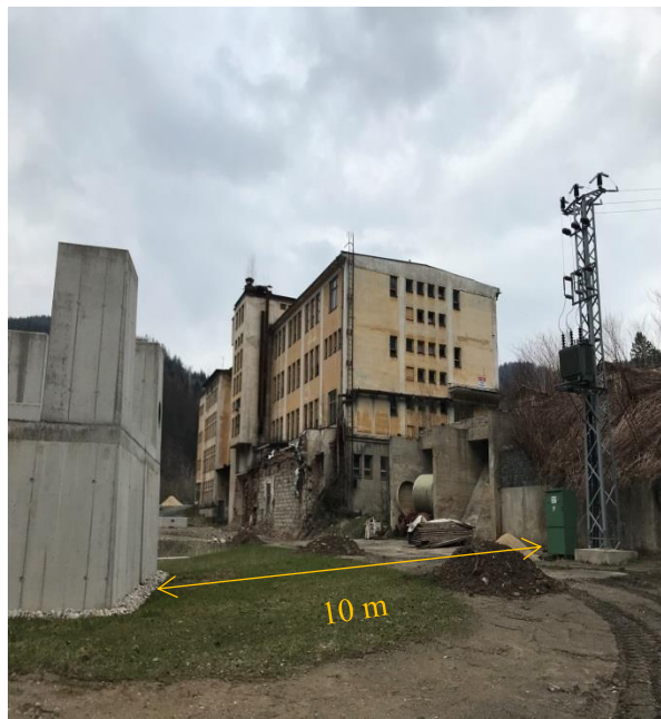
Obr. 34- Vzdálenost TR stanice od strojovny
