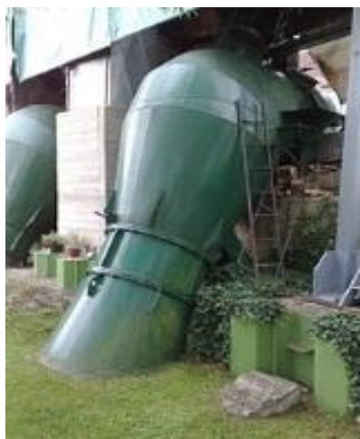
Obr. 18- Praktické provedení savky
