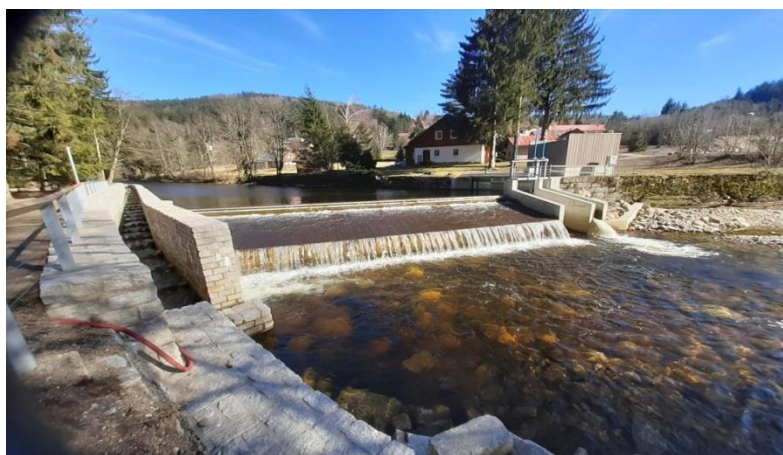
Obr. 11- Jez Vilémov s jalovým přepadem
