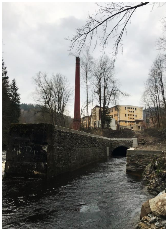
Obr. 37- Odpadní kanál MVE Vilémov
