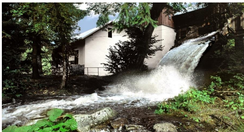
Obr. 5- MVE Čeňkova pila (v provozu od roku 1912), [1]
