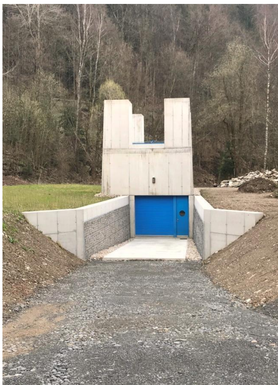
Obr. 39- Strojovna MVE Vilémov
